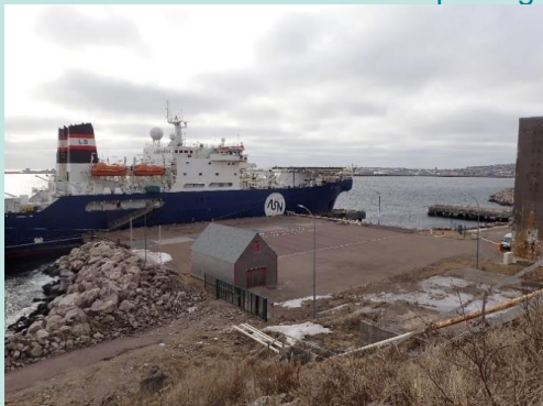
Quai en eaux profondes actuel avec navire accosté et bâtiment d'accueil des passagers
